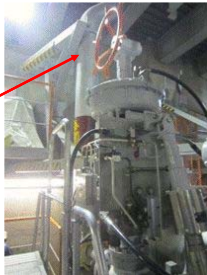
主蒸気逃がし弁
