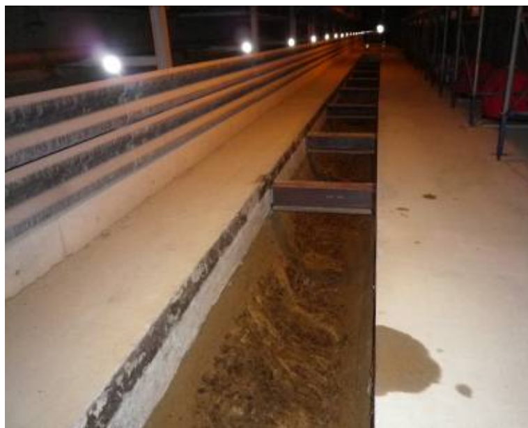
図10 陀羅山トンネル底盤コンクリート剥ぎ取り状況
