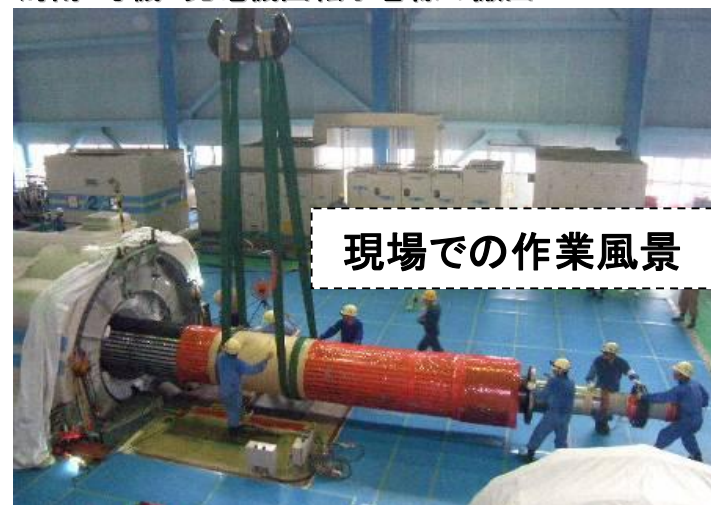
海南2号機 発電機回転子巻線の搬出
