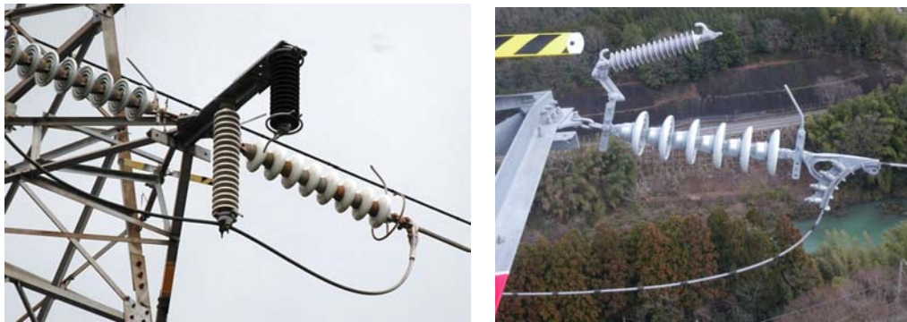
図2 送電用避雷装置とホーン型の送電用避雷装置の写真例
