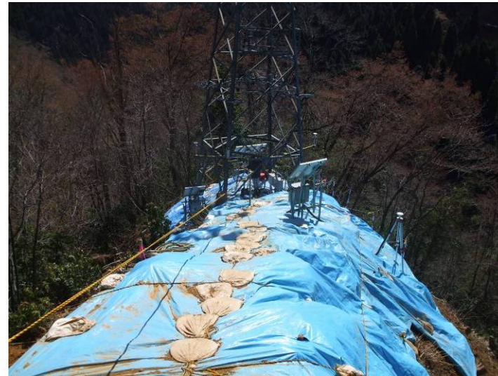
(現在の状況: 応急対策実施済み)
