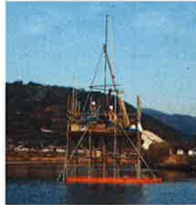
単管パイプやぐら(浅水域)
