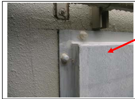
貫通部 (窓：シールゴムを挿入し鉄板で閉止)
