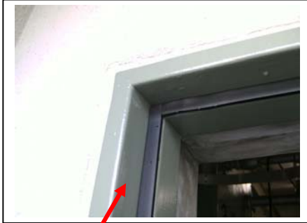
扉 (片開き：シールゴム施工)
