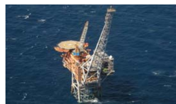
[ガス生産井プラットフォーム]
