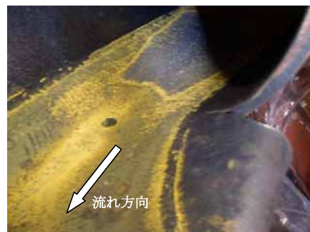
⑦-1 ドレン穴周辺
