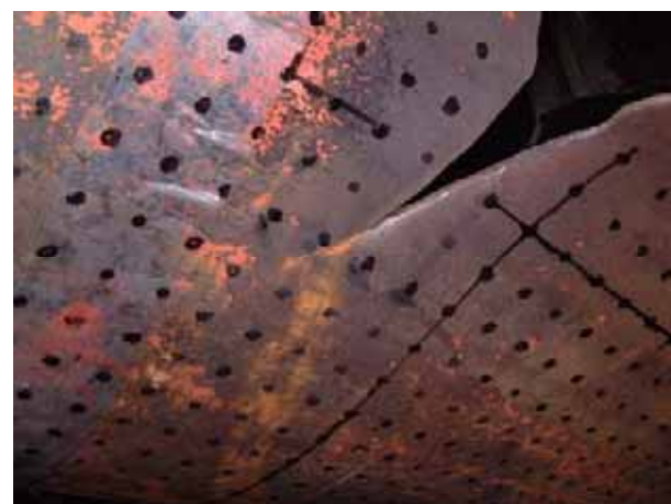
④ き裂停止部(下流側から観察)
