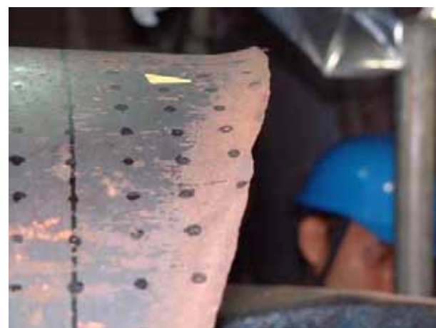
② 配管破損部(下流側から観察)
