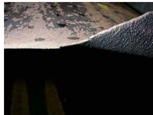
③ 三角形めくれ上がり部根本付近
