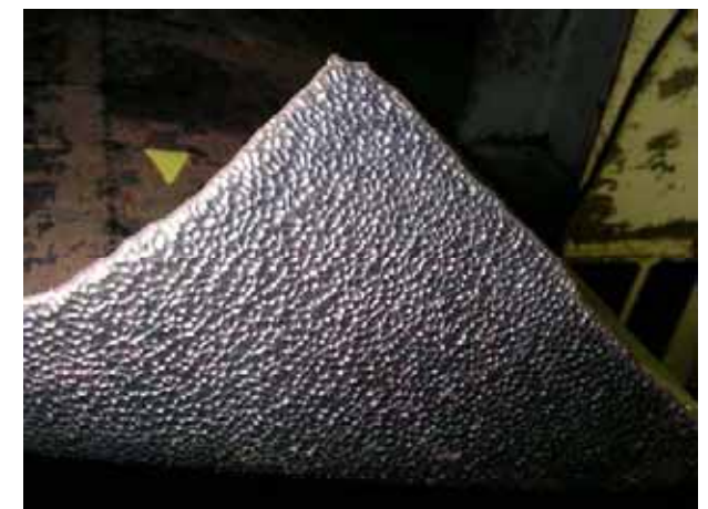
④ 三角形めくれ上がり部頂点付近
