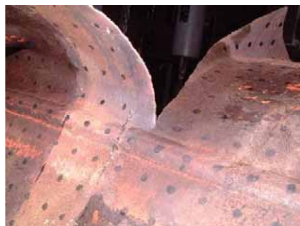
① き裂停止部外観(下流側から観察)
