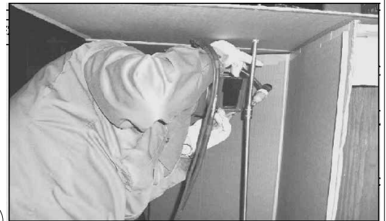
当該箇所の模擬溶接作業状況写真
