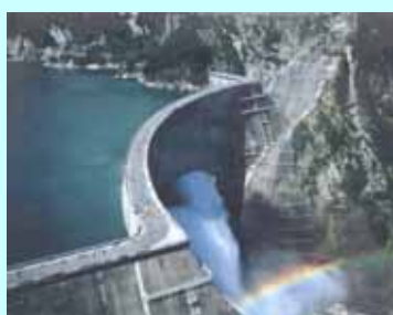
黒部川第四発電所 (33.5 万 kW、水力)
