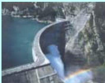
黒部川第四発電所(33.5万kW、水力)
