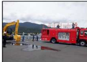
使用済燃料ピット送水作業
