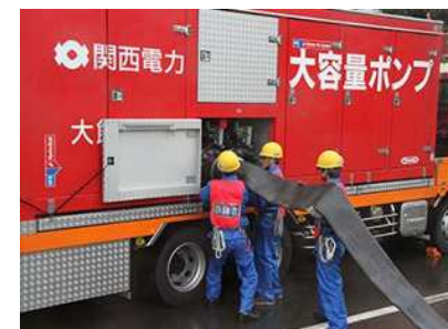
大容量ポンプ設置訓練
