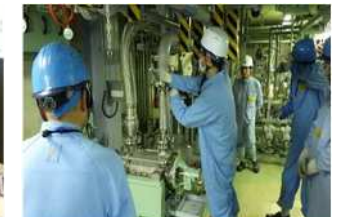
仮設中圧ポンプによる給水訓練
