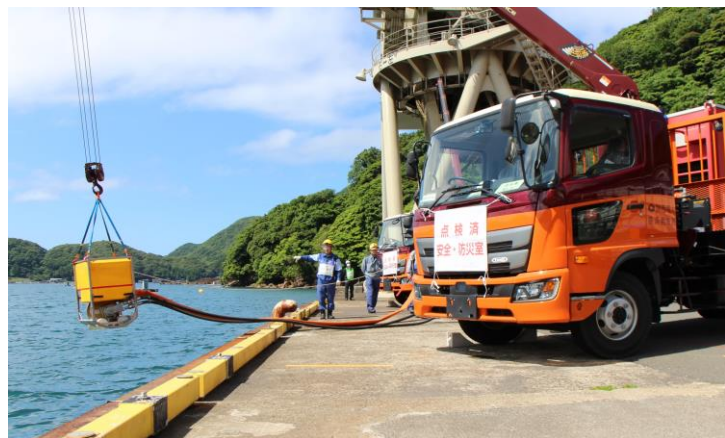
訓練の実施状況（高浜発電所）
