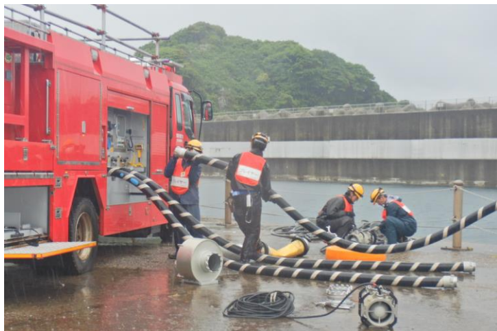
訓練の実施状況（大飯発電所）
