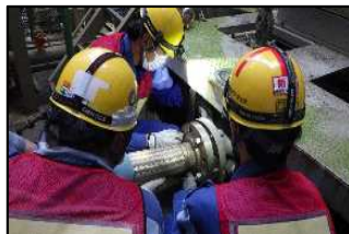
仮設中圧ポンプ接続訓練
