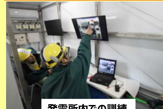
発電所内での訓練
