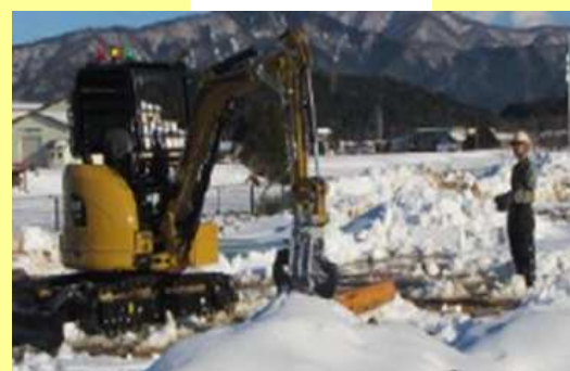
無線重機訓練
