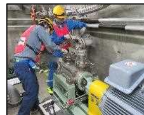
仮設中圧ポンプ接続訓練
