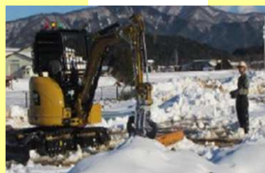
無線重機訓練
