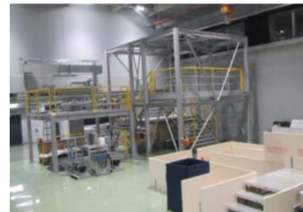
事務所棟 訓練施設
