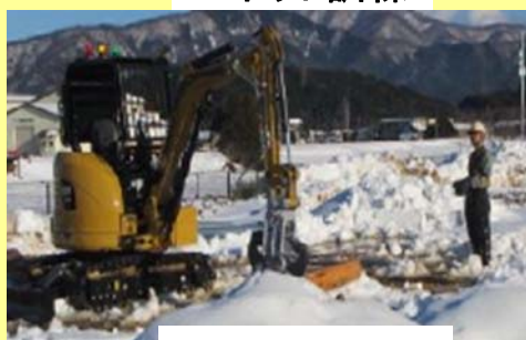
無線重機訓練
