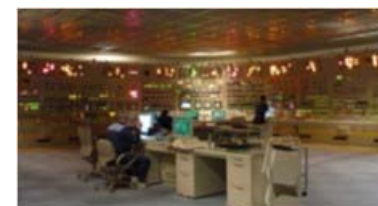
シミュレータ訓練 （非常灯照明下）
