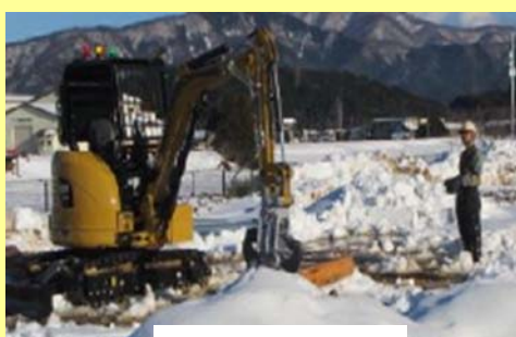
無線重機訓練
