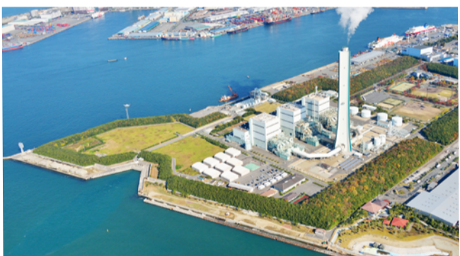
■南港発電所 外観
