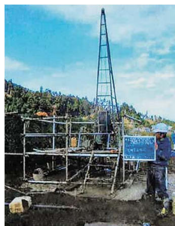
ボーリング調査イメージ
