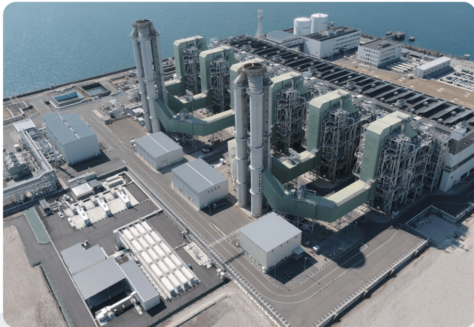
姫路第二発電所
