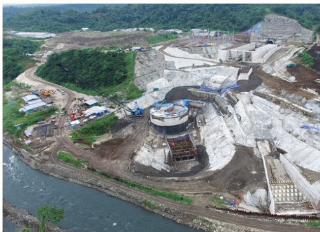
発電所エリアの状況
