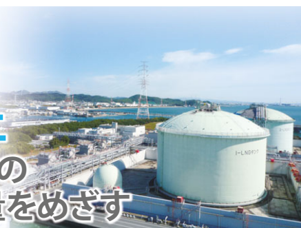
姫路第二発電所構内のLNGタンク
