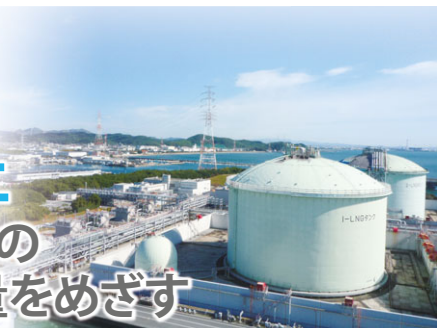
姫路第二発電所構内のLNGタンク
