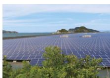
有田太陽光発電所
