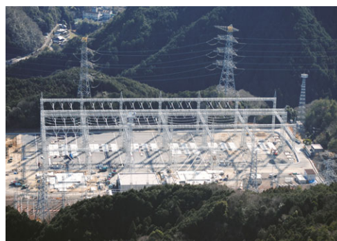
500kV変電所新設工事
