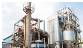
関電ジオレ(株)の汚染土壌処理施設(高温熱処理設備)
