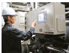
「あべのハルカス」のユーティリティ設備を点検
