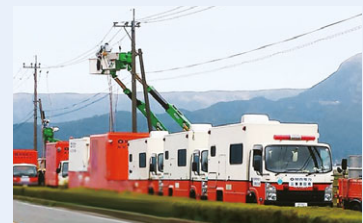
応急送電をおこなう当社高圧発電機車
