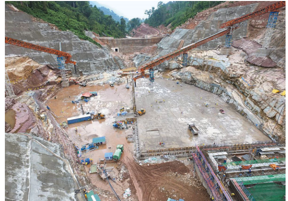
ダム建設現場
