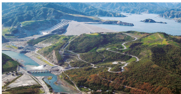
フィリピン共和国サンロケ水力発電所全景
