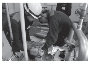
点検作業のOJT
