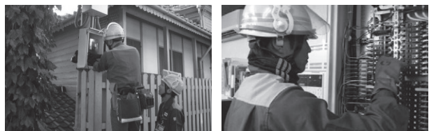
北野異人館「萌黄の館」の電気設備点検 (兵庫県神戸市)
