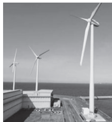
田原4区風力発電所
