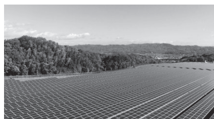
けいはんな 太陽光発電所
