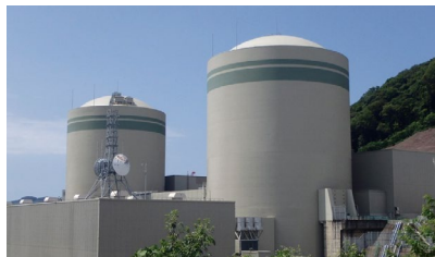
高浜発電所1、2号機 原子炉格納容器上部 遮へい設置工事
