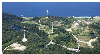
淡路風力発電所
