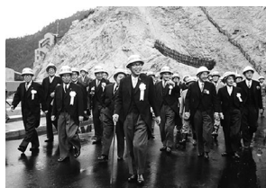
1963年 黒部川第四発電所(通称くろよん)竣工 7年にわたる難工事の末、竣工。電力供給をはじめ日本の経済成長に貢献
