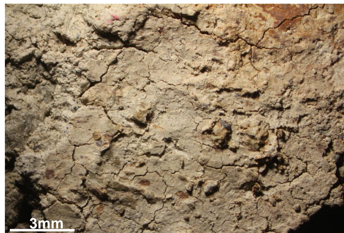
断層面の状況
