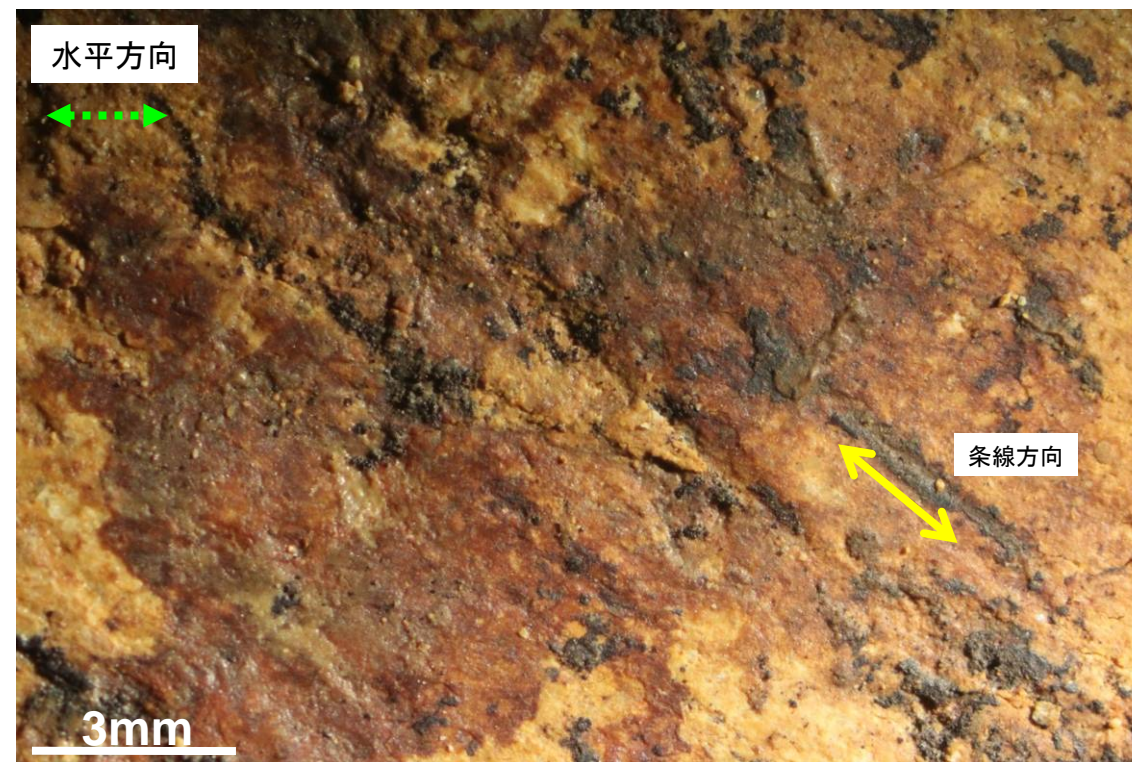
断層面の状況
