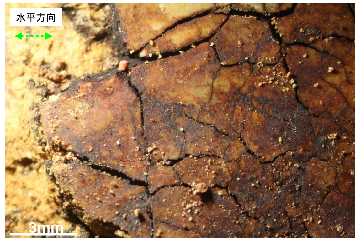
断層面の状況
