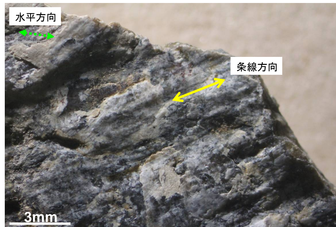
断層面の状況
