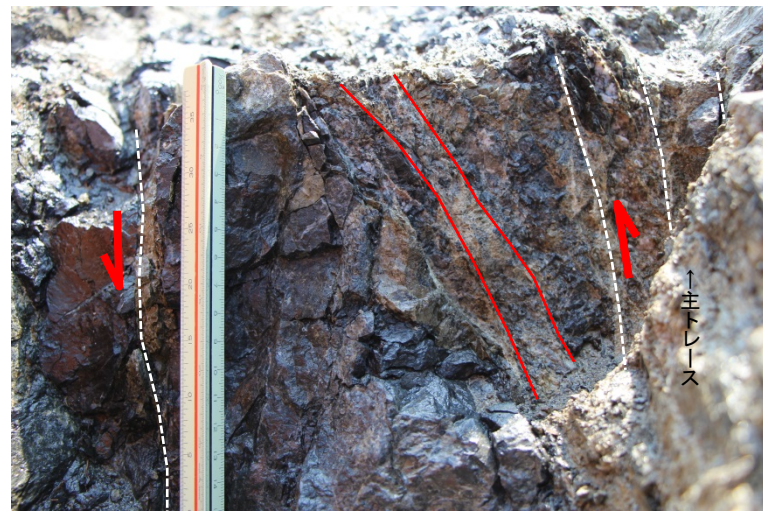
拡大写真4(鉛直断面) 角礫状破碎部(弱変形)中に正断層センスを示すR1面が認められる。
