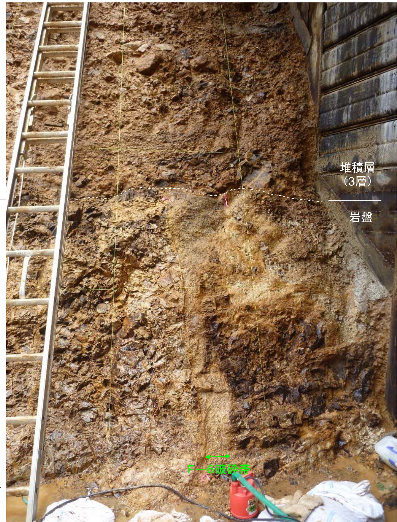
写真3(北側側壁、トレンチ東端の破碎帯)
