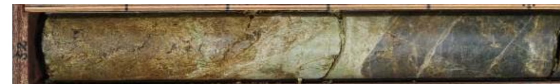
深度52.20m 傾斜70°の割れ目沿い幅1cm程の固結した細粒石英閃緑岩中の角礫状破碎部(N14W/87E)。断層ガウジは伴わず。F-6破碎帯。
