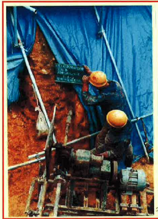
F-6破碎帯 トレンチ北西面側
