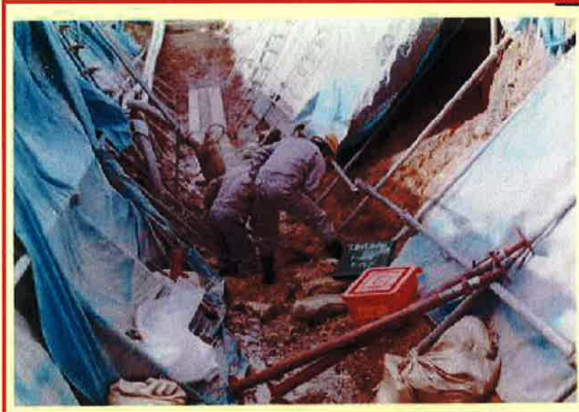
F-6破碎帯 トレンチ北西面側
