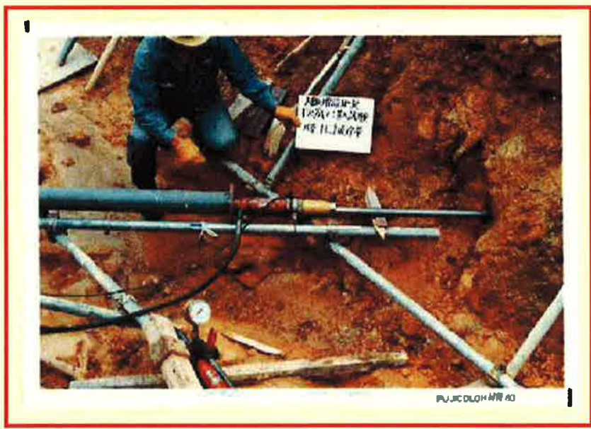
F-6 破碎帯 トレンチ北西面側
