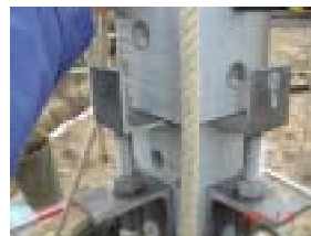
鉄塔の分離・接合用 「ジャッキ金具」 箱型部材を分離・接合する際部材を所定の位置まで支持する金具で、調整ナットを回すことで上下微調整が可能となる（この金具を使用することにより、連結部に作業員が不要となり安全に切り離し可能）
