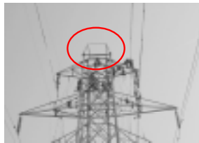
鉄塔の分離・接合用 「鉄塔受けガイド」 鉄塔組立時に、ヘリコプターから箱型部材を下ろしていく際にガイドとなる (紙コップを重ねるイメージ)
