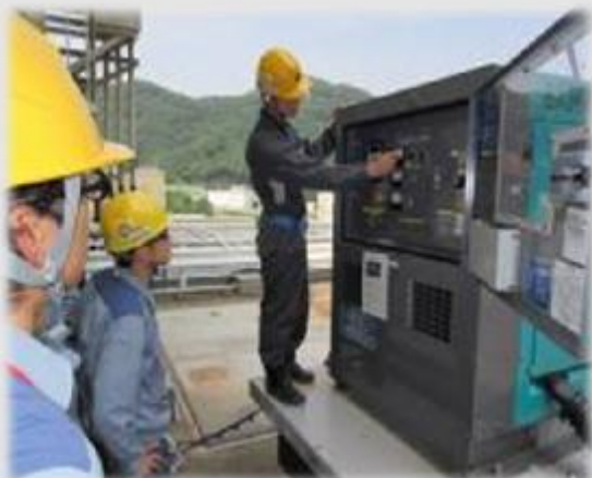
＜中圧ポンプ用発電機取扱い訓練＞
