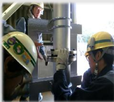
＜大容量ポンプ系統切換に係る訓練＞
