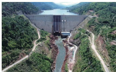
ナムニアップ1発電所
