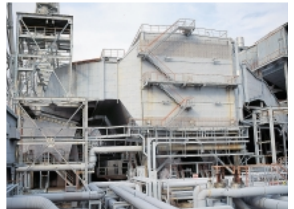
Electrostatic precipitator (Kainan Power Station)
