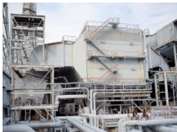
Electrostatic precipitator (Kainan Power Station)
