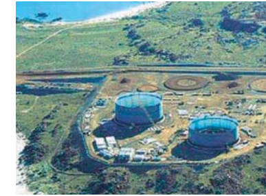
● Pluto construction site (Pluto LNG Project)
