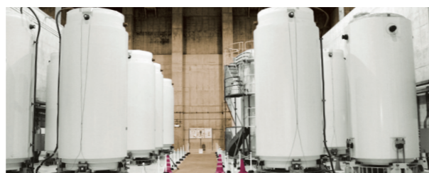
東海第二発電所(日本・茨城県)
