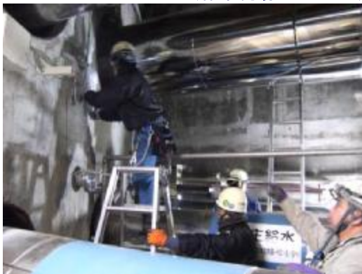
設備の保全や労働安全等の観点から現場の状況を確認
