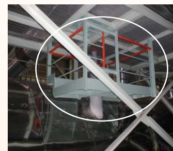
例:2次系配管高所サポートの専用架台を設置 (改善前は、近くの架台から作業を実施)
