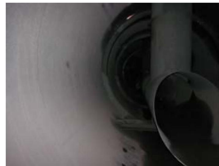
脱気器内部の天井板、スプレイノズル等異常なし
