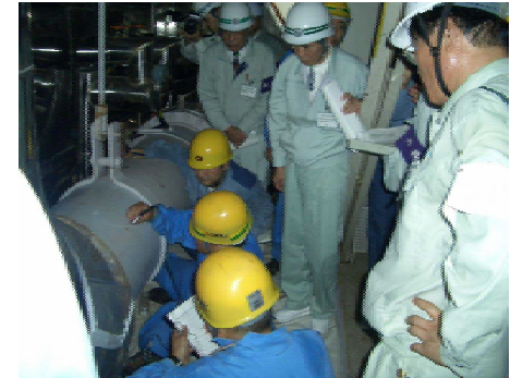
2次系配管点検
