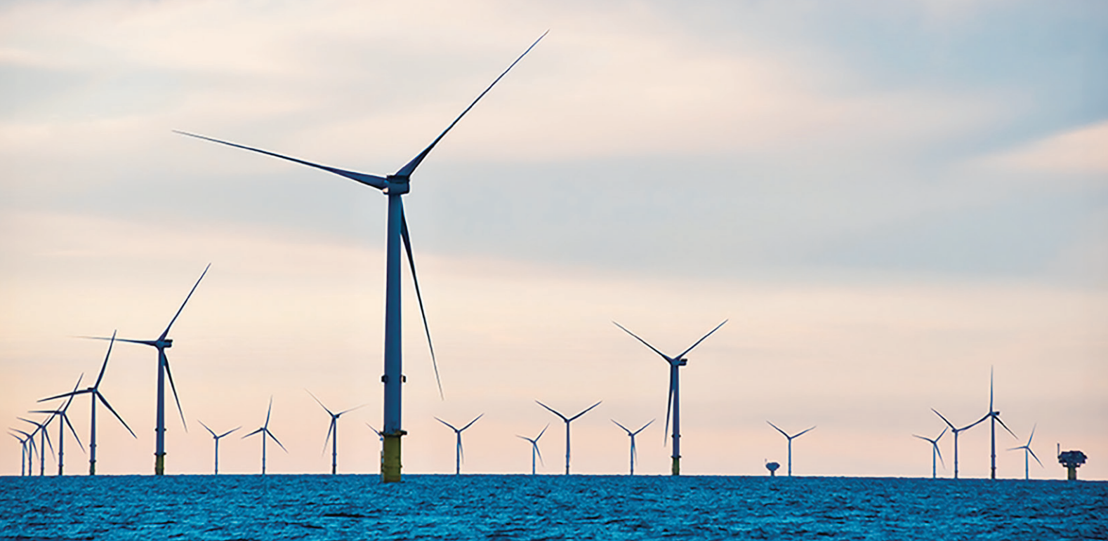
英国・トライトンノール洋上風力発電事業は22年4月に商業運転を開始した
