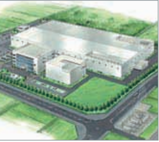
リチウムイオン二次電池の製造を担う(株)リチウムエナジー ジャパンの新工場完成予想図(滋賀県栗東市)
