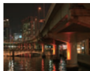
堂島川では、阪神高速道路橋脚の常設ライトアップが開始され、中之島に新たな光の風景が加わりました(2008年12月から点灯開始)
