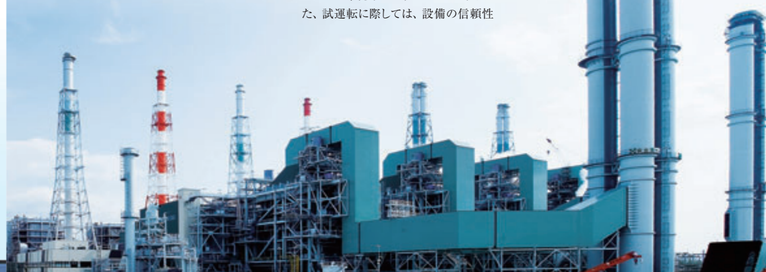
新設堺港発電所
