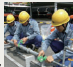
ガス漏洩修理訓練
