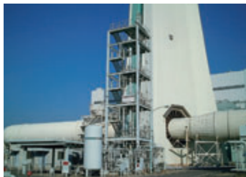
排煙脱炭のための試験プラント (南港発電所)
