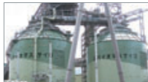
バイオマスサイロ（舞鶴発電所）
