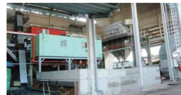
間伐材などの焼却設備の排熱を新たな目的に利用
