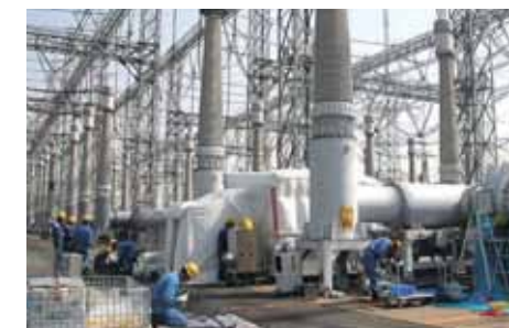
変電所での保守・点検作業
