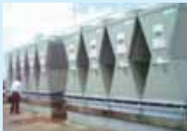
ご採用いただいた電気式空冷ヒートポンプチラー
