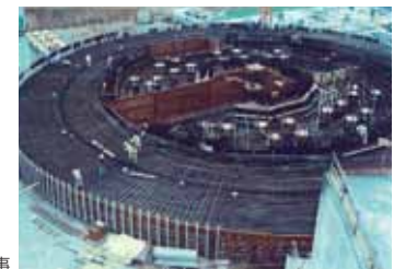
原子炉建屋の基礎工事
