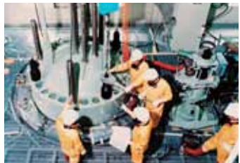
実機と同等の原子炉容器を使い、上蓋のボルト締付け作業を訓練
