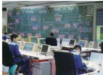
電気を絶えずコントロールする中央給電指令所
