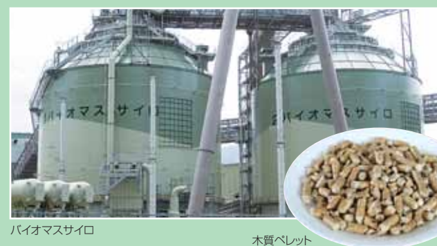
舞鶴発電所では、石炭をボイラーで燃焼させる既存の設備に、バイオマスサイロなどを追加し、木質ペレットを石炭といっしょに燃焼させて蒸気をつくる
