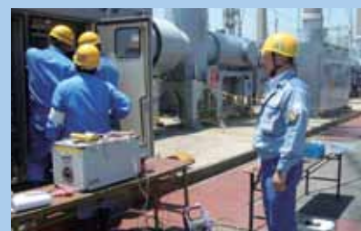
500kVガス遮断器の細密点検の指導
