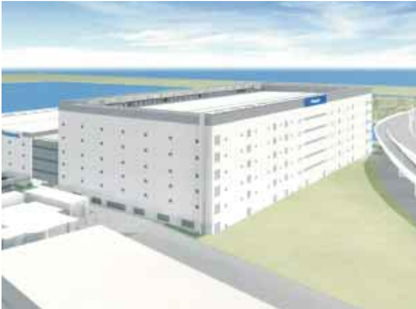
▲ 当社発電所跡地に建設中の松下プラズマディスプレイパネル新工場
