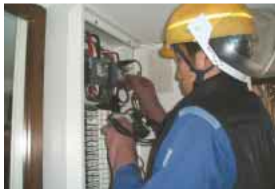
漏電調査のようす
